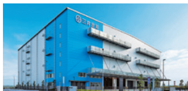
CASBEEのAランクを取得した三井倉庫(株)南本牧倉庫
